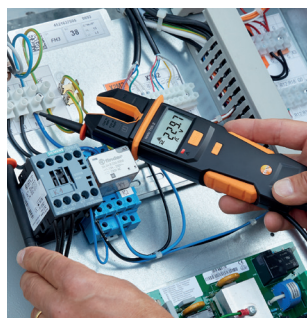
Misura della tensione su un compressore.
